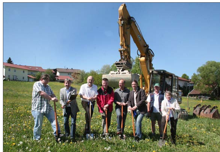
Beim Spatenstich für das Appartementhaus in der Pfarrer-Fersch-Straße: (von links) Heimbeirats-Vorsitzender Thomas Trs, Geschäftsführer Jochen Fischer, Lebenshilfe-Vorsitzender Josef Weinhuber, Bauleiter Christian Fischer, Ludwig Wurm von der beauftragten Baufirma Zankl, der Leiter des Ambulant-unterstützten-Wohnens Bernhard Moissl, Zankl-Mitarbeiter Ludwig Fischer und Lebenshilfe-Wohnbereichsleiterin Sylvia Hartinger. – Fotos: Albrecht
