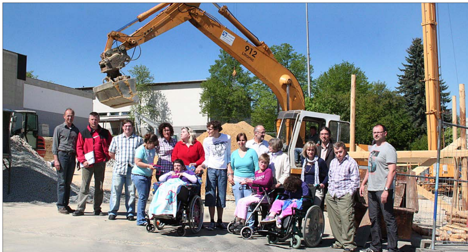
Freuen sich, dass mit dem Bau der Förderstätte gleich neben der Lebenshilfe-Wohnanlage begonnen wurde: Bewohner der Lebenshilfe Wohnanlage mit Mitarbeitern und Vertretern der Lebenshilfe, der beauftragten Baufirma und des Architekturbüros Brunner.
